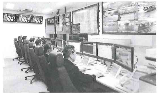
消防指令センターの様子
