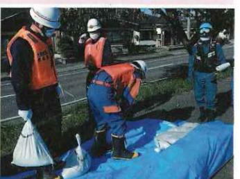
▲雨量が急激に増え水路から越水し住宅へ流入することを防止する目的で実施するのが「積み土のう工法」です。
